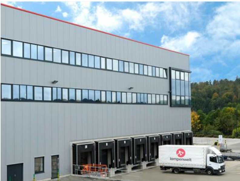
Das Logistikzentrum der Lampenwelt GmbH im Schlitzer Stadtteil Frauombach.
